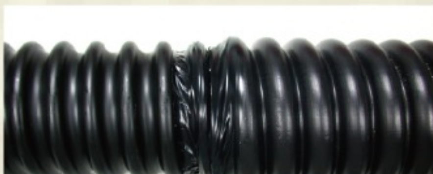
圖四:再將直接頭兩端與導電線管接合處再以寬防水膠帶貼合即可
